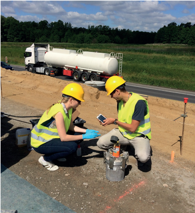
Rys. 4. Urządzenie Super Air Meter w użyciu na placu budowy drogi
