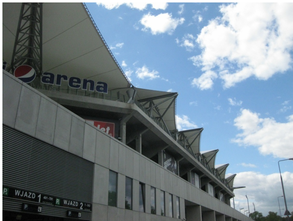
Rys.1. Widok północnej trybuny stadionu "Legii" od strony ul. Łazienkowskiej.
