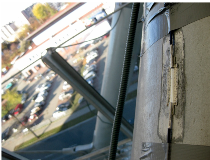
Rys. 4. Zgrzany punktowo czujnik odkształceń nogi dźwigara.
