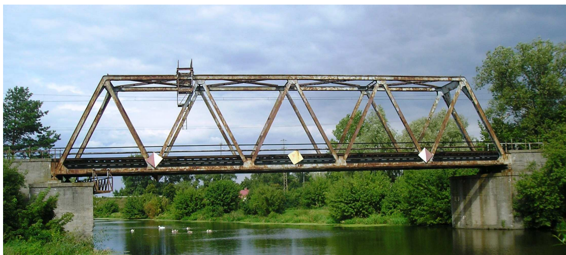
Rysunek 1.1: Most kolejowy w Nieporęcie k. Warszawy.
