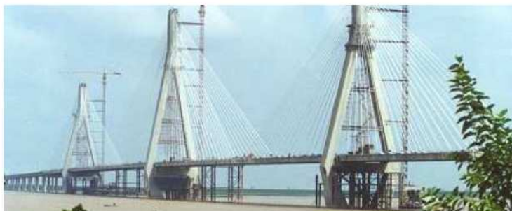
Rysunek 3.8: Most Dong Ting Lake w Chinach wykorzystujący liniowe tłumiki z cieczą magnetoreologiczną do minimalizacji wpływu wiatru na jego przemieszczenia (materiały firmy LORD Corporation).
